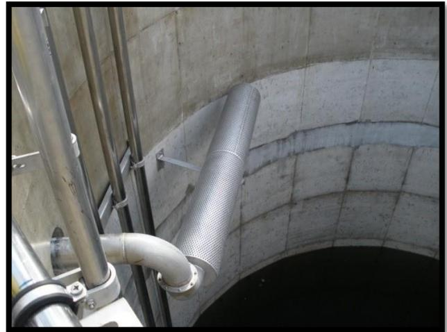
*Exemplos de larga escala de telas de retenção adequadas para o MixLife BioChip 30*
