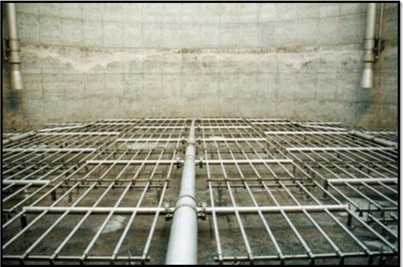
*Sistema de aeração regularmente alocado sobre toda a superfície do fundo do tanque.*
