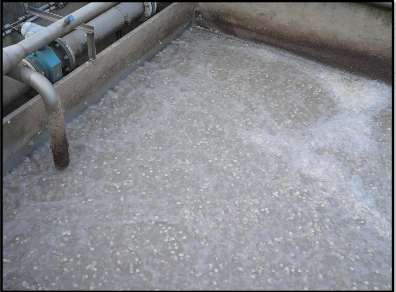
*O mesmo tanque alguns dias depois; Devido a condições ótimas de processo, as mídias MixLife BioChip 30 foram colonizadas pelo biofilme em alguns dias e estão completamente submersas no efluente.*
